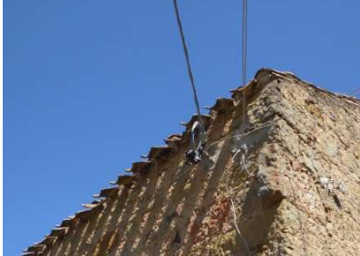
Aggetto semplice con coppi canale
